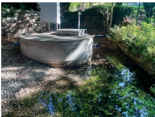
Remise en service source Font Pétugue Méounes-lès-Montrieux juillet 2023
